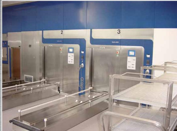
Dampf-Groß-Sterilisatoren der Serie ECS werden in hoher Qualität nach Industriestandards gefertigt. Große Kammervolumen ermöglichen den geforderten Sterilgutdurchsatz in großen Aufbereitungseinrichtungen. Das großflächige Touch-Display an der Beladeseite bildet die benutzerfreundliche Schnittstelle zum System. Die Dokumentation aller Prozessdaten erfolgt vollautomatisch. Belade- und Entladesysteme verschiedener Fabrikate lassen sich vollständig in die Systemsteuerung integrieren.
