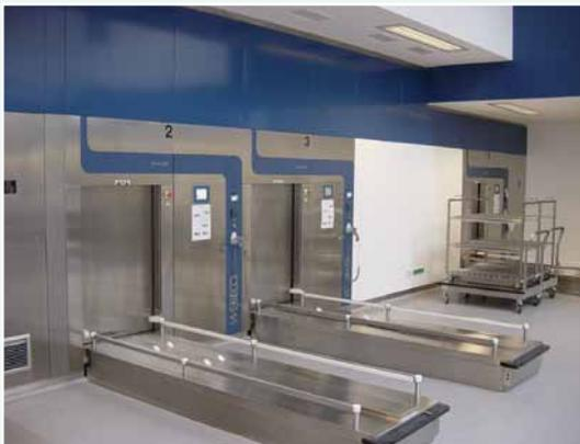
Bequemes Einfahren großer Mengen von Sterilisiergütern in die ECS-Sterilisierkammer. Serie ECS-Dampf-Groß-Sterilisatoren sind nicht nur für das WEBECO-Transport- und Beschickungssystem ausgelegt, sondern auch für handelsübliche Transportsysteme als Bestandteil der Krankenhaus-Logistik.
